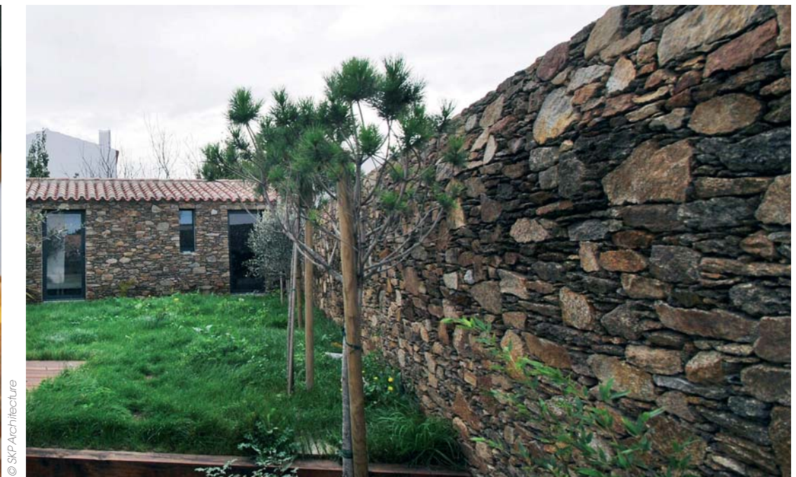
▲ Accès à la parcelle avec une annexe au fond.
