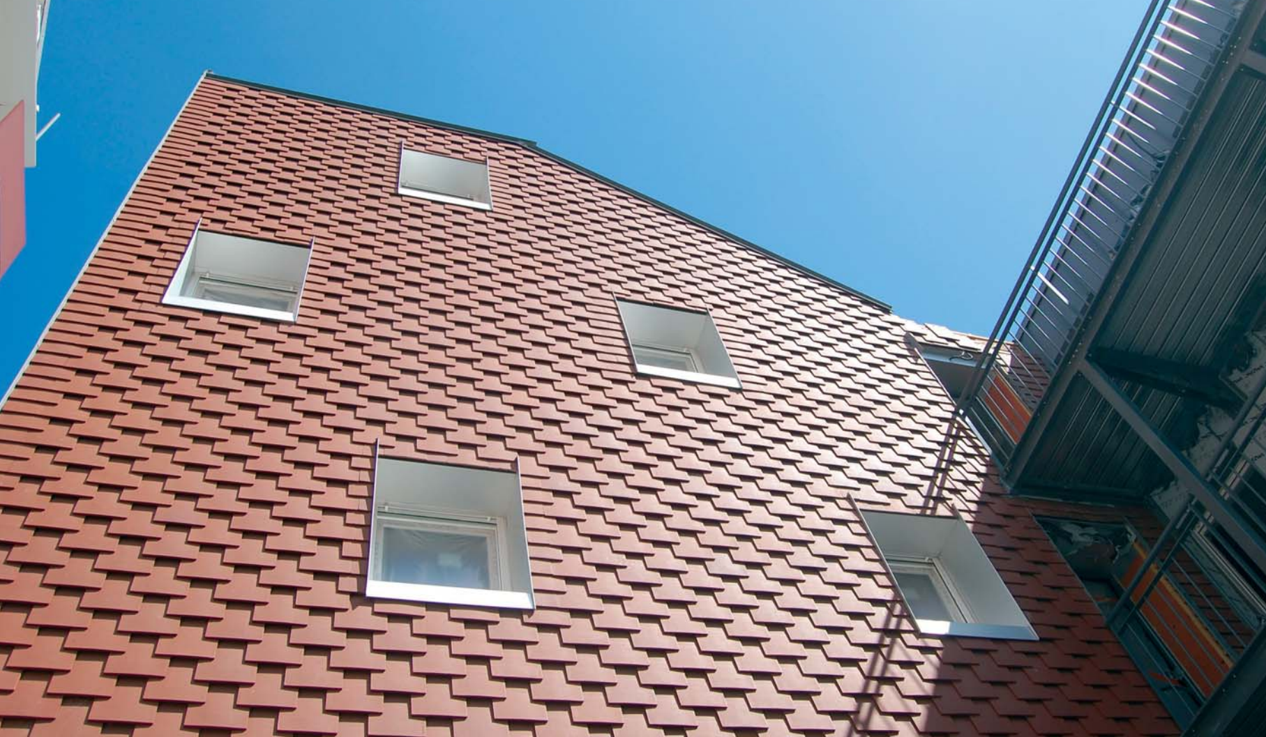
▲ Vêtiture et isolation thermique façade cour.
