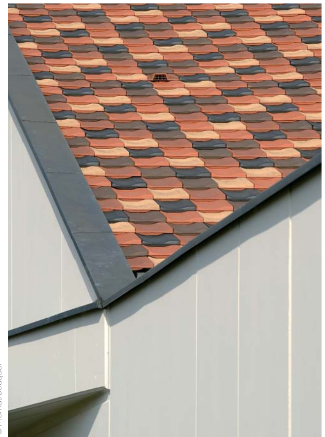
▲ Traitement des rives par couventines et « noue-couloir » en tôle plastée.
