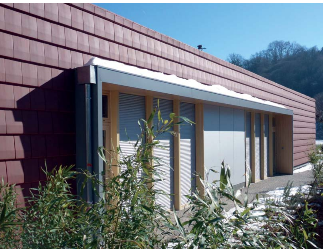
▲ Façade ouest : surfaces vitrées regroupées sous un auvent récupérant les eaux pluviales de la toiture.
