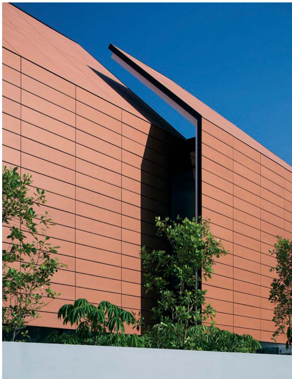
▲ Détail de l'enveloppe ouest. La terre-cuite possède des propriétés naturelles d'absorption du bruit.
