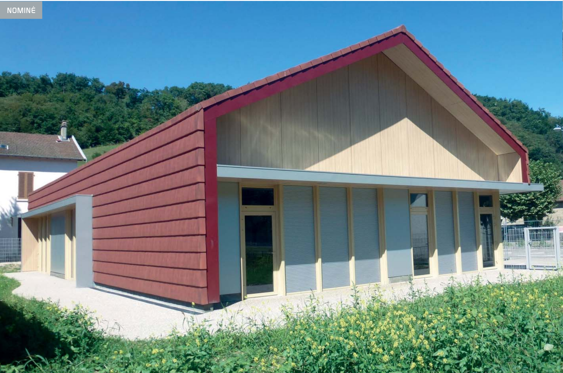
▲ 1.20 m de débord de toit protège la façade sud du soleil.
