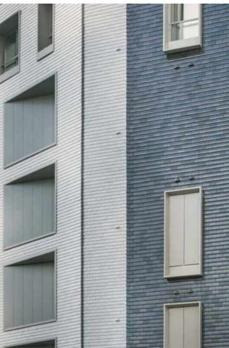
▲ Détail de la façade.
