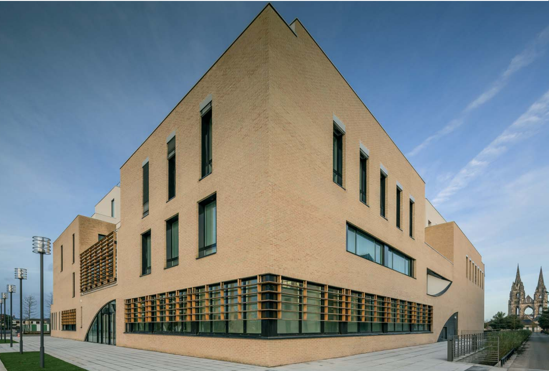
▲ Socle compact en brique. Angle sud ouest, accès au conservatoire.
