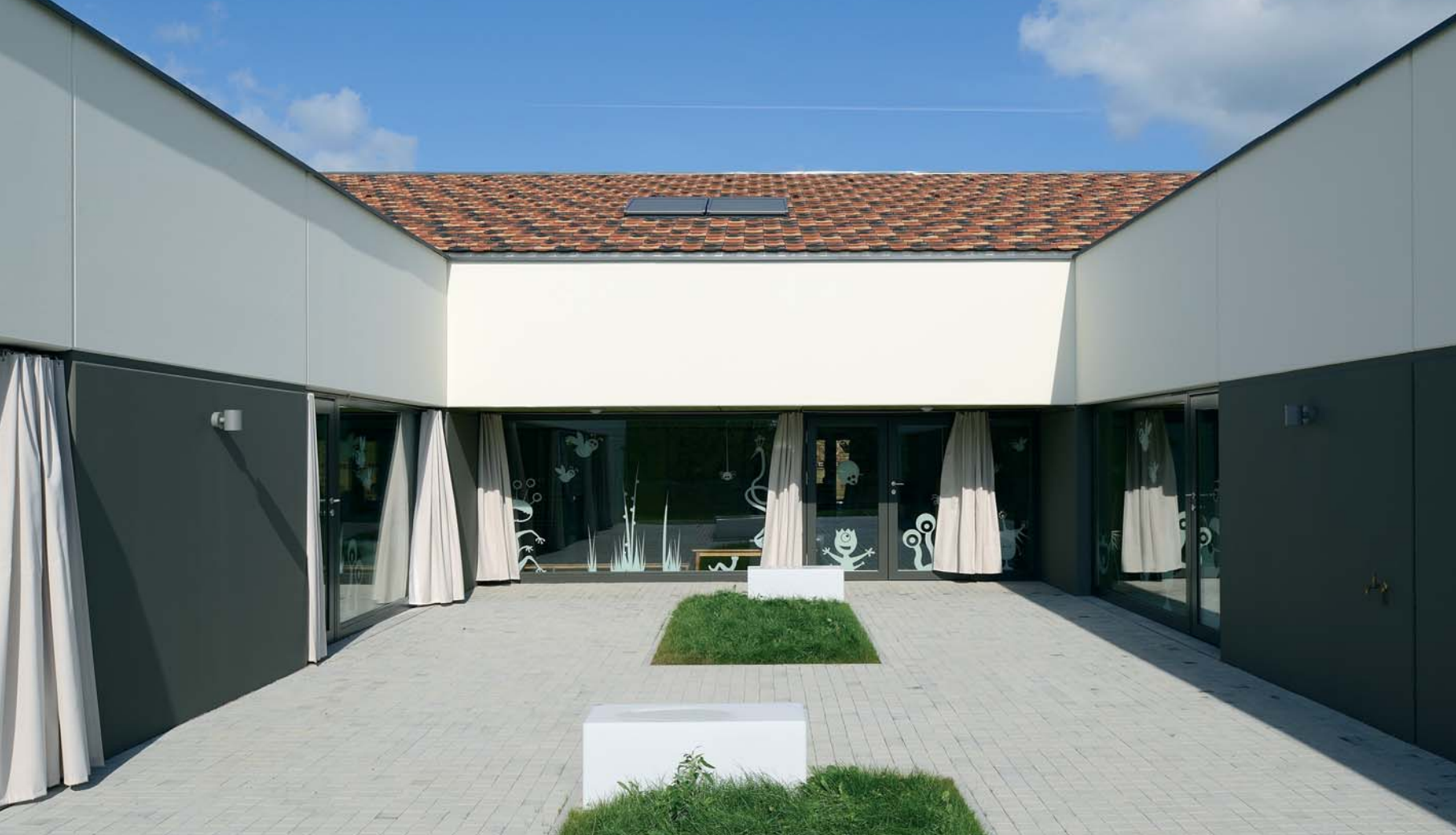
▲ Présence de la toiture rampante depuis le patio.
