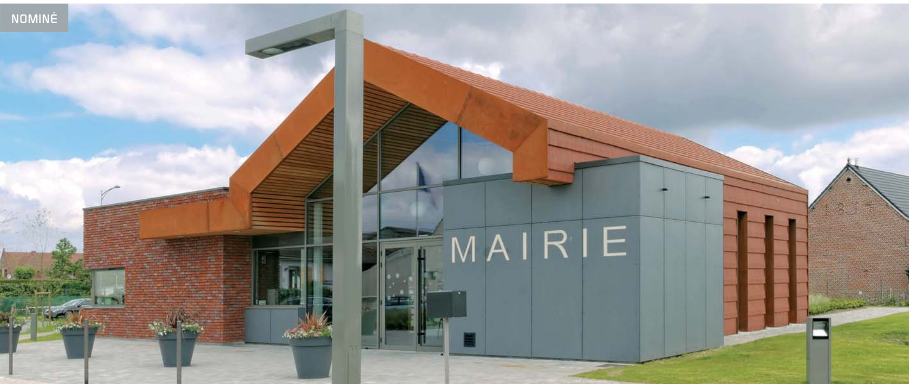
▲ polychromie et texture (brique, tuile et corten) crée le signal fort dans le village pour cet équipement.
